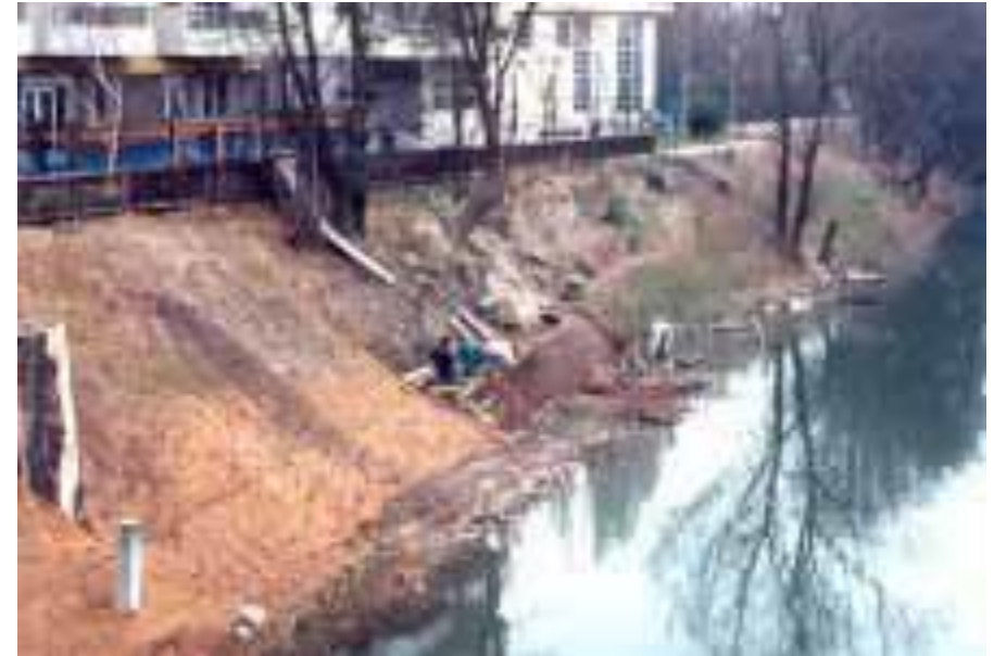
Etat de l'ouvrage avant les travaux entre 1997 et 1998
