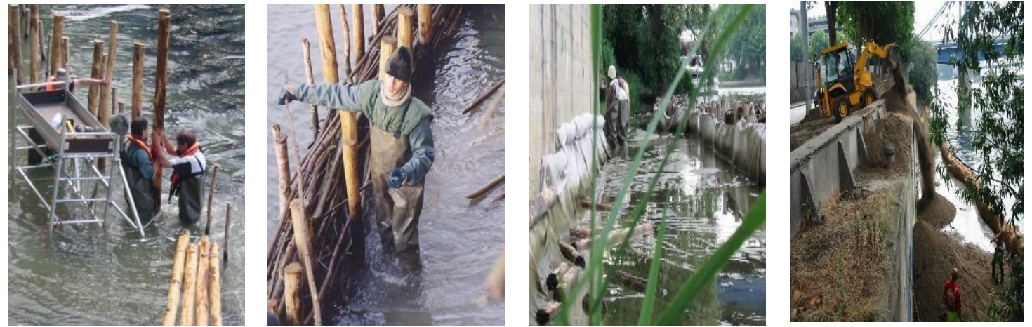
En cours de travaux
