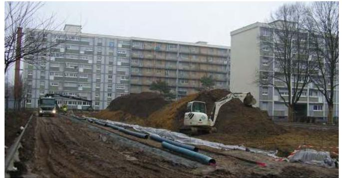
Pose des drains, remplissage gravier roulé et fermeture du géotextile
