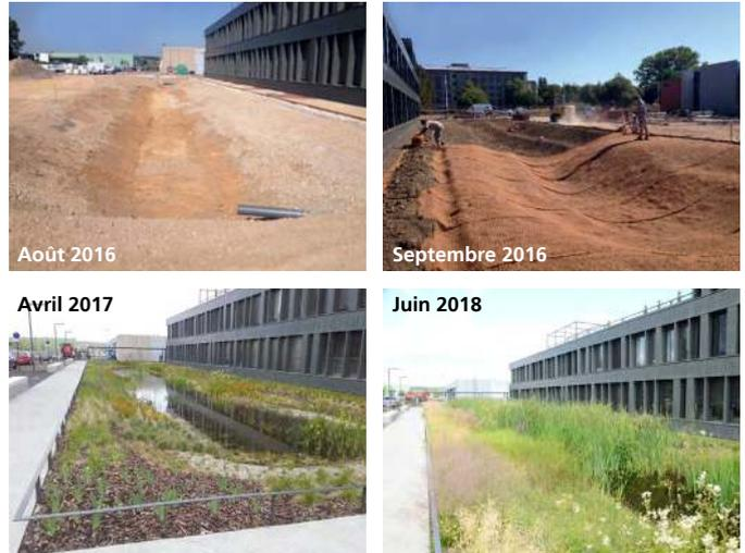
**Photo 11** : étapes de réalisation d'une noue étanche à mi-hauteur (milieu humide permanent et infiltration de l'excédent)
