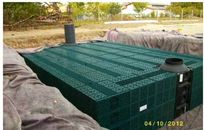
**Photo 12** : caissons d'infiltration (blocs drainants) sous un futur aménagement accessible aux véhicules légers
