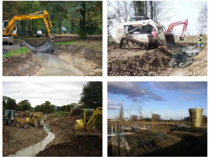
Nappage à l'argile et recouvrement en terre végétale argileuse
