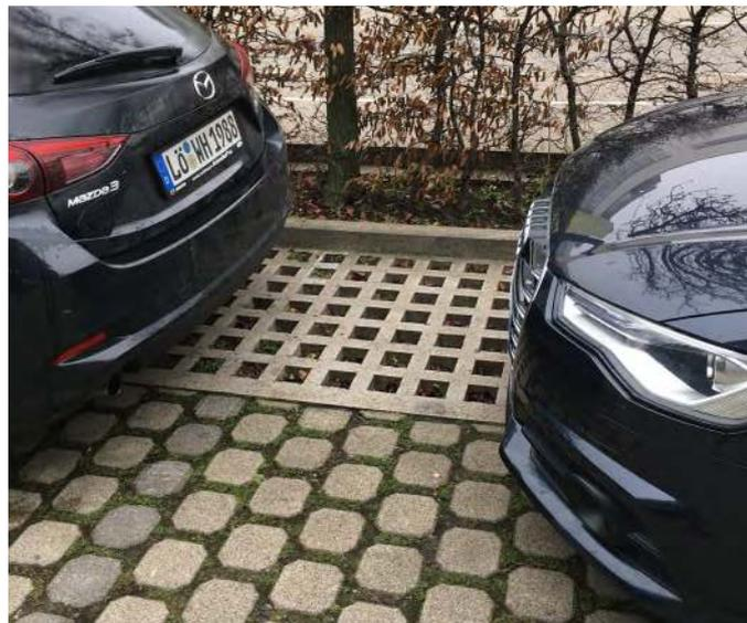
**Photo 13** : surface de stationnement en pavés béton à joints engazonnés
