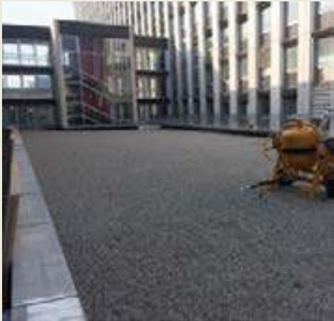
Mise en œuvre d'une couche drainante continue sur géotextile de protection
