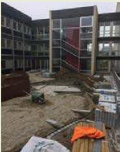
Pose des éléments de séparation métalliques et files pavés sur solins en béton continus
