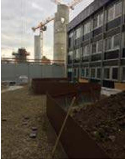
Pose des éléments de séparation métalliques et files pavés sur solins en béton continu
