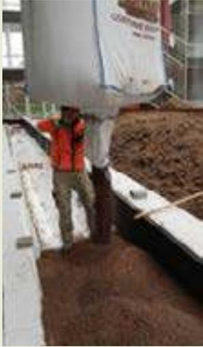
Mise en œuvre de substrat pour les zones où son épaisseur est inférieure à 30 cm
