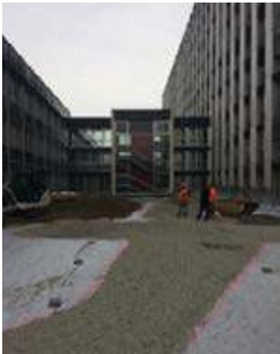
Mise en œuvre d'une couche filtrante continue lestée par des gravillons de lit de pose au droit des futures allées
