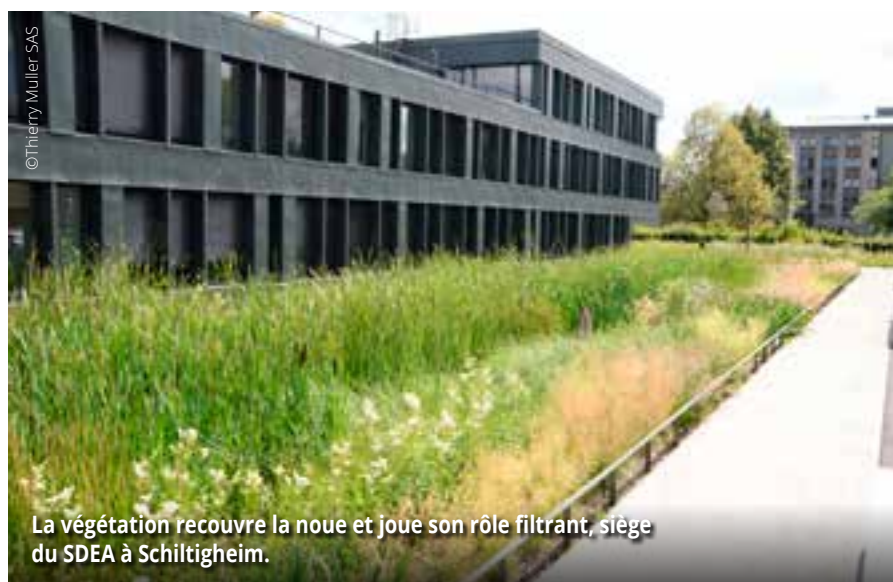
Chantier de végétalisation d'une noue pour la collecte des eaux pluviales, siège du SDEA à Schiltigheim
