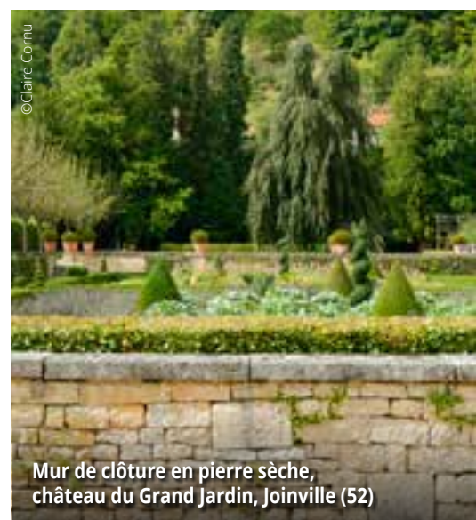
Mur de soutènement de terrasse
