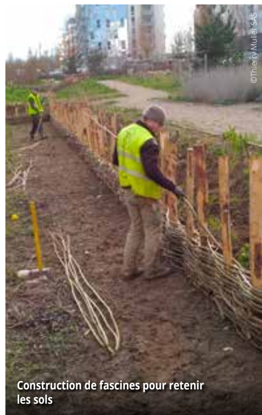
Opération de confortement de berges
