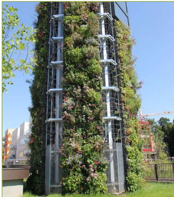
Figure 3 : photo de végétalisation de façade par gabions. Source : T. Muller.
