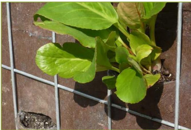
**Figure 18** : photo d'une plantation par incision de la toile de protection extérieure. Source : T. Muller.
