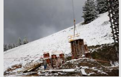
© Gael Kerbaal / INRS Chantier de BTP en hiver
