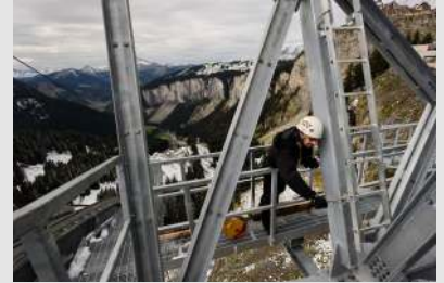
© Gael Kerbaal / INRS Travail en altitude (Ici chantier de construction d'un téléphérique en montagne)
