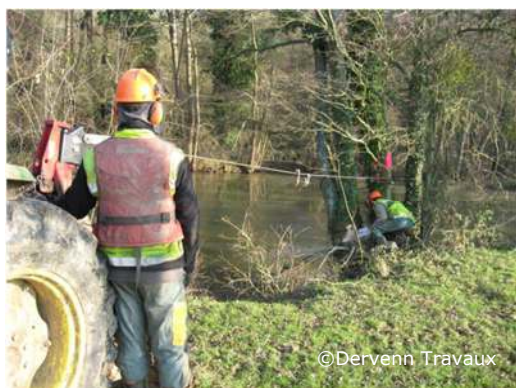
Photos ci-dessus : Abattage d'un arbre penchant vers la rivière puis extraction de l'arbre
