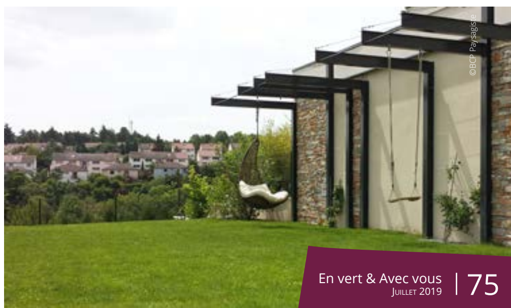
Aménagements avec des structures IPN
