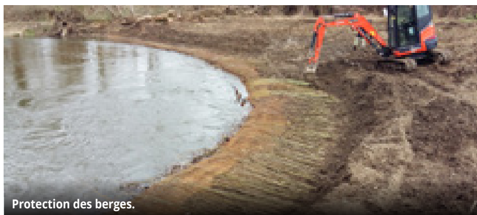
Réalisation d'un peigne en toile de coco.
