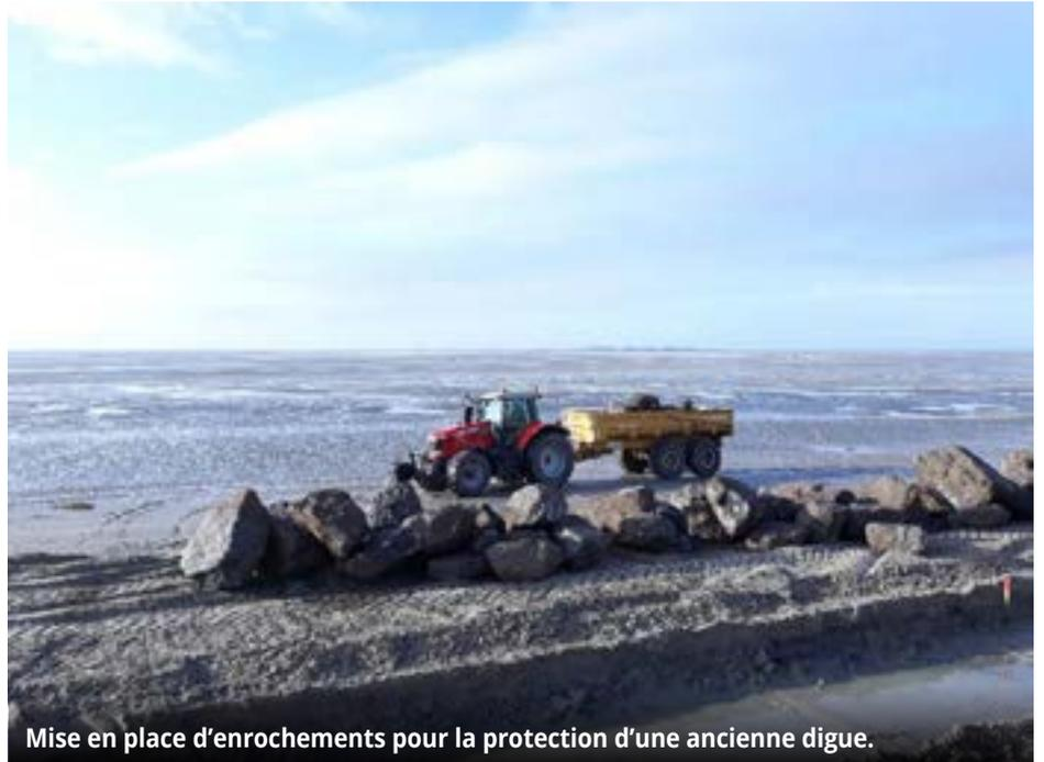
Mise en place d'enrochements pour la protection d'une ancienne digue.
