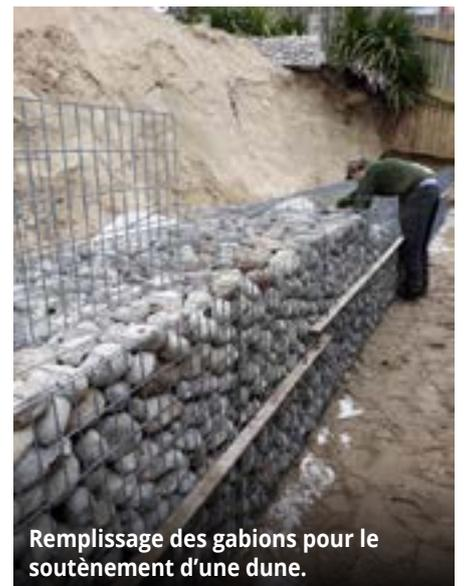
Remplissage des gabions pour le soutènement d'une dune.
