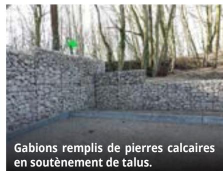
Gabions remplis de pierres calcaires en soutènement de talus.
