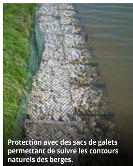
Protection avec des sacs de galets permettant de suivre les contours naturels des berges.
