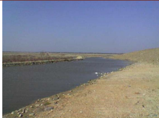
Berges après travaux de terrassement 2006
