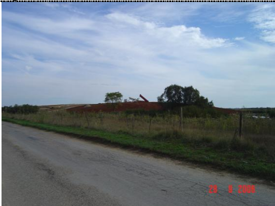
Vue générale après terrassement 2006
