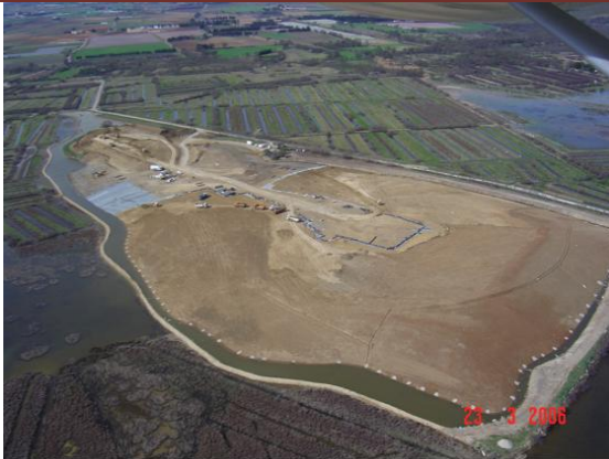
Photographie aérienne chantier terrassement 2006
