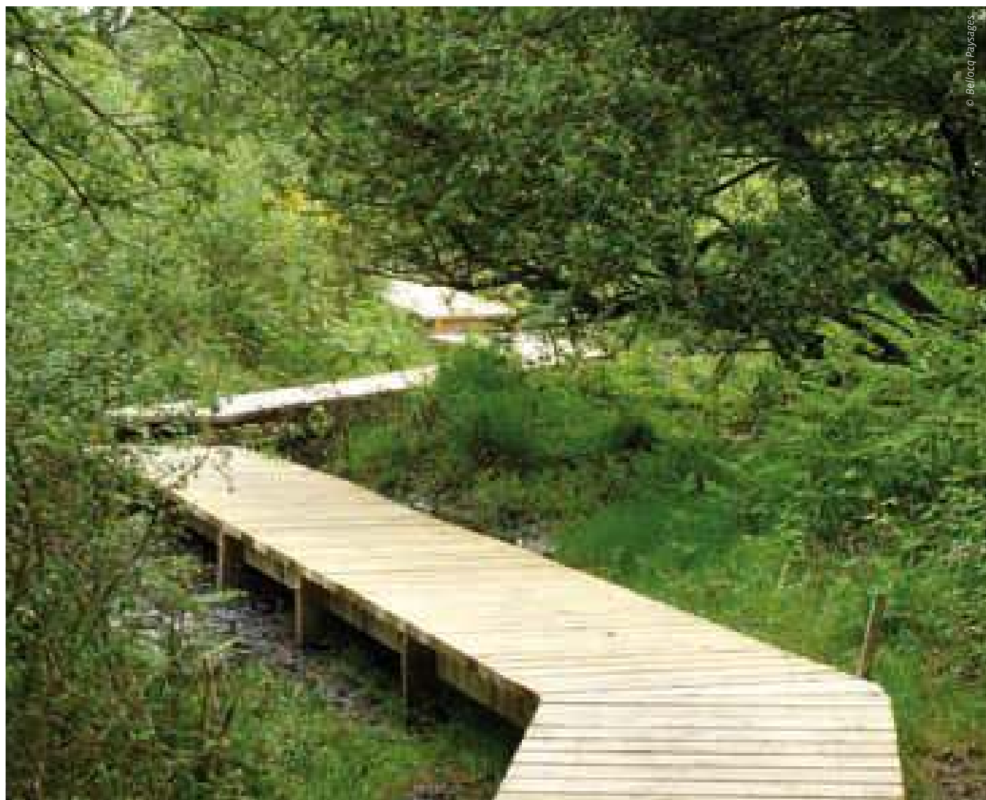
Passerelle en bois réalisée en zone naturelle humide.
