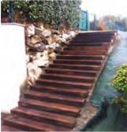
Aménagement d'une terrasse
