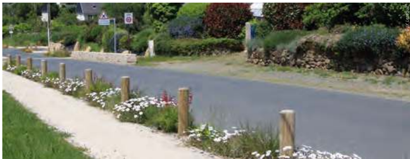
Aménagement de voie piétonne, Trélévern
