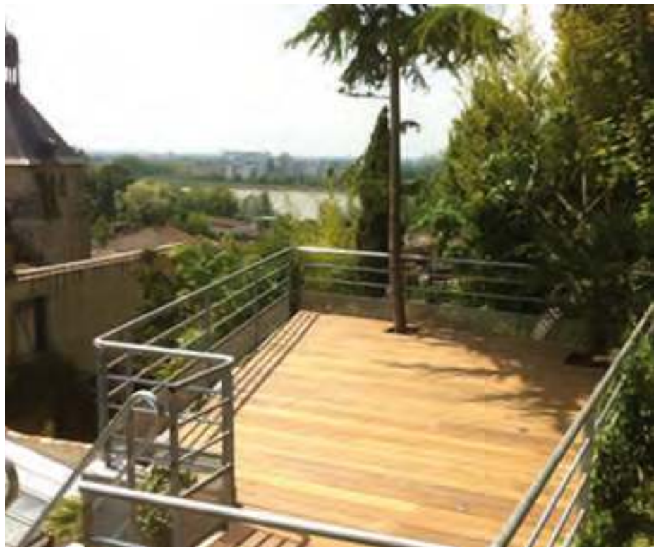
Aménagement d'une terrasse
