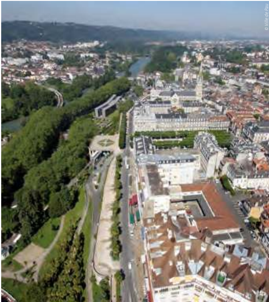
Vue aérienne, coulée verte autour du Gave, Pau
