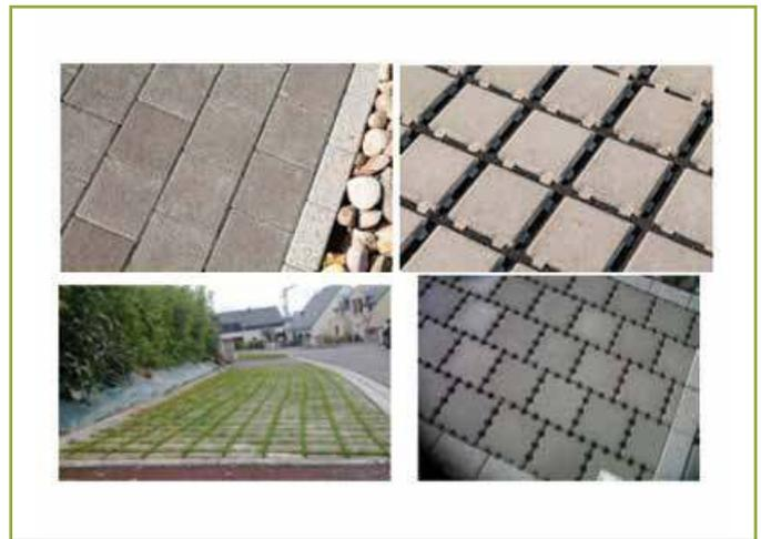
Figure 11 : Photos de différents types de revêtements perméables de pavés et de dalles en béton (source : Cérib, document DP 115)
